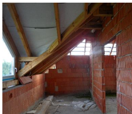
sanitrace zdiva v místě, kde chybí tašky na střeše
