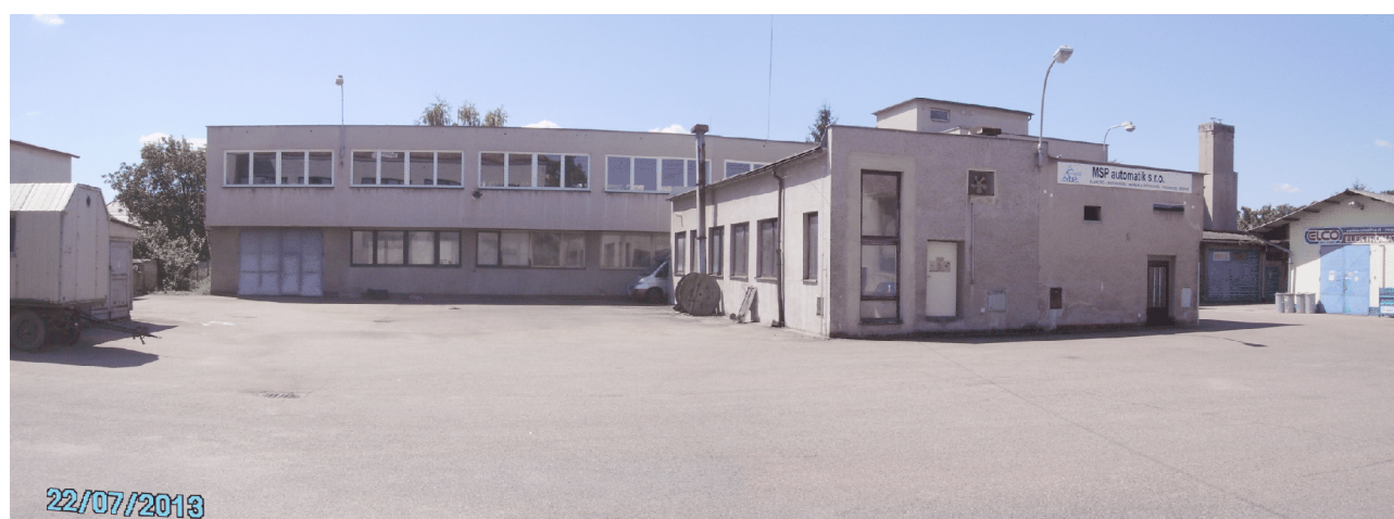
Hlavní výrobní budova na p.p.č. 475/3
