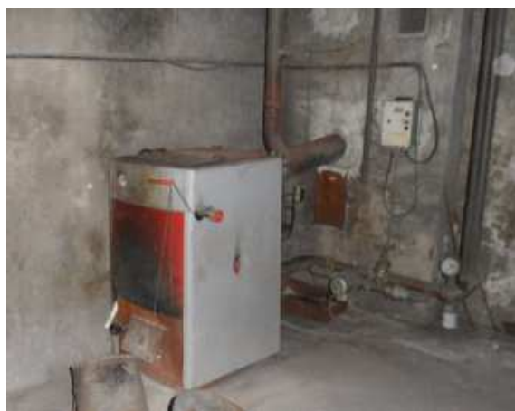
kotel na tuhá paliva v suterénu objektu
