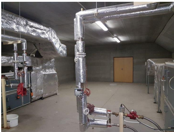
technologie vzduchotechniky restaurace na půdě
