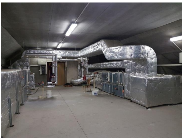
technologie vzduchotechniky restaurace na půdě
