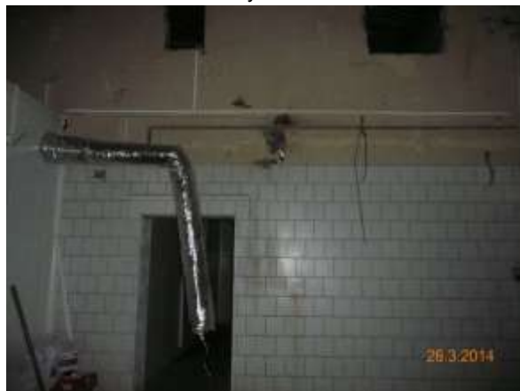
Poškozené potrubí VZT
