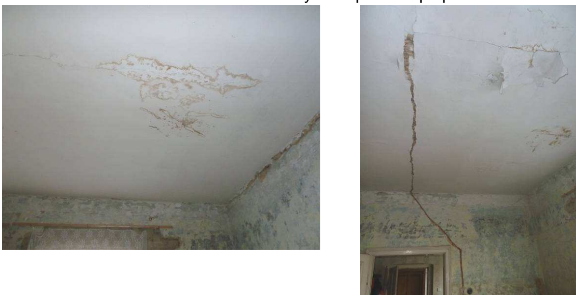
viditelné stopy na stropě po zatečení a v minulosti započatá a nedokončená rekonstrukce rozvodů el.energie
