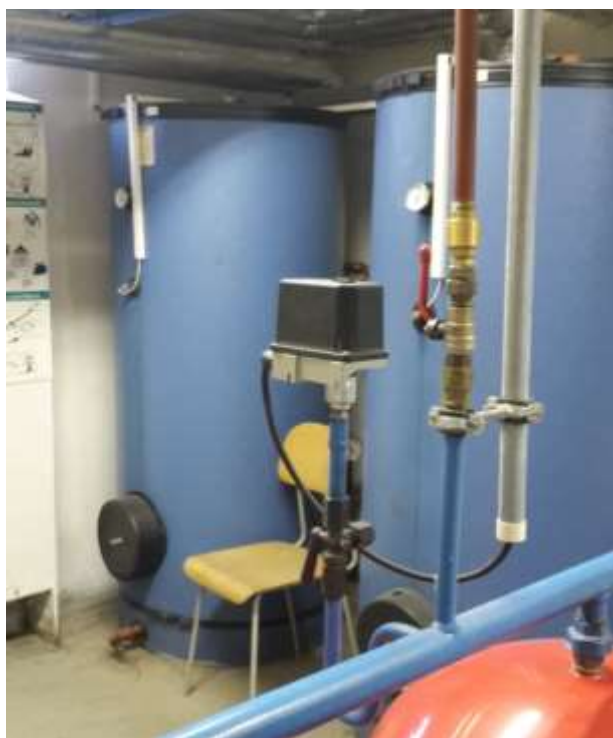
Obrázek 9: Příprava TV – stojaté ohříváky
