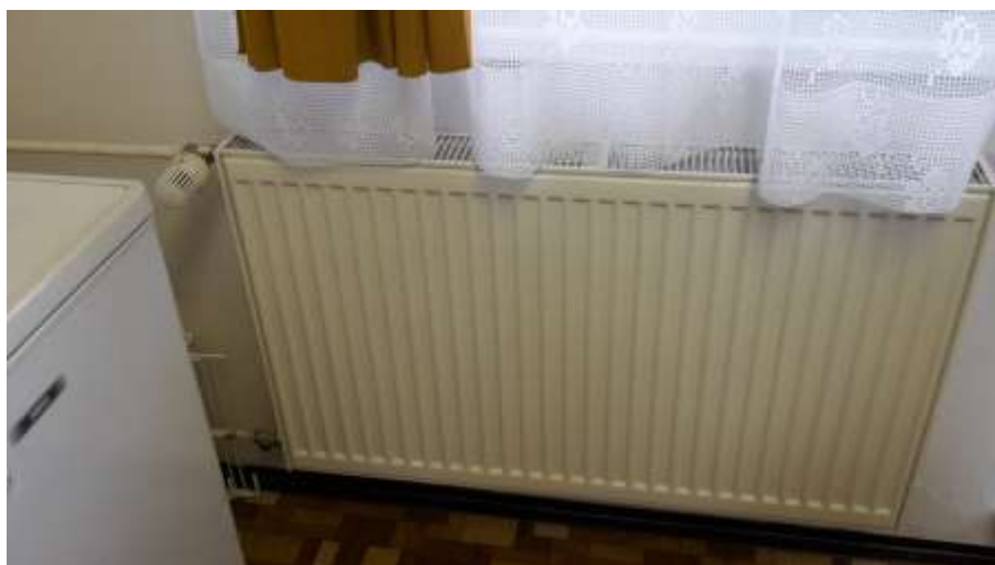
Obrázek 8: Otopná desková tělesa
