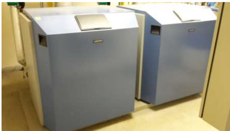
Obrázek 6: Kotle Hydrotherm Eurotemp Mistral HEM 240.D
