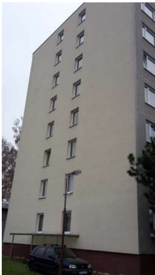
Obrázek 11: Pohled na zateplenou fasádu objektu
