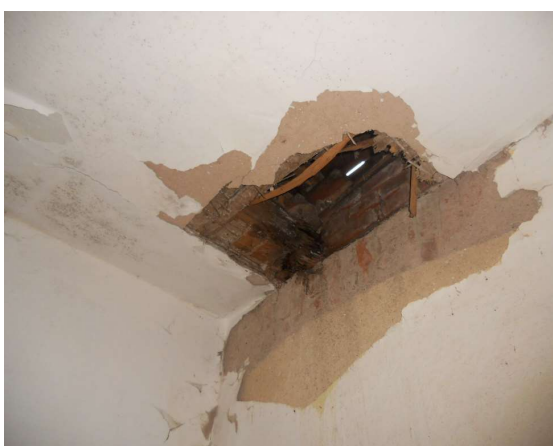
Poškození stropů v části domu
