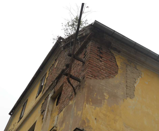
Vlivem zatékání vody je stavba na mnoha místech zcela degradována
