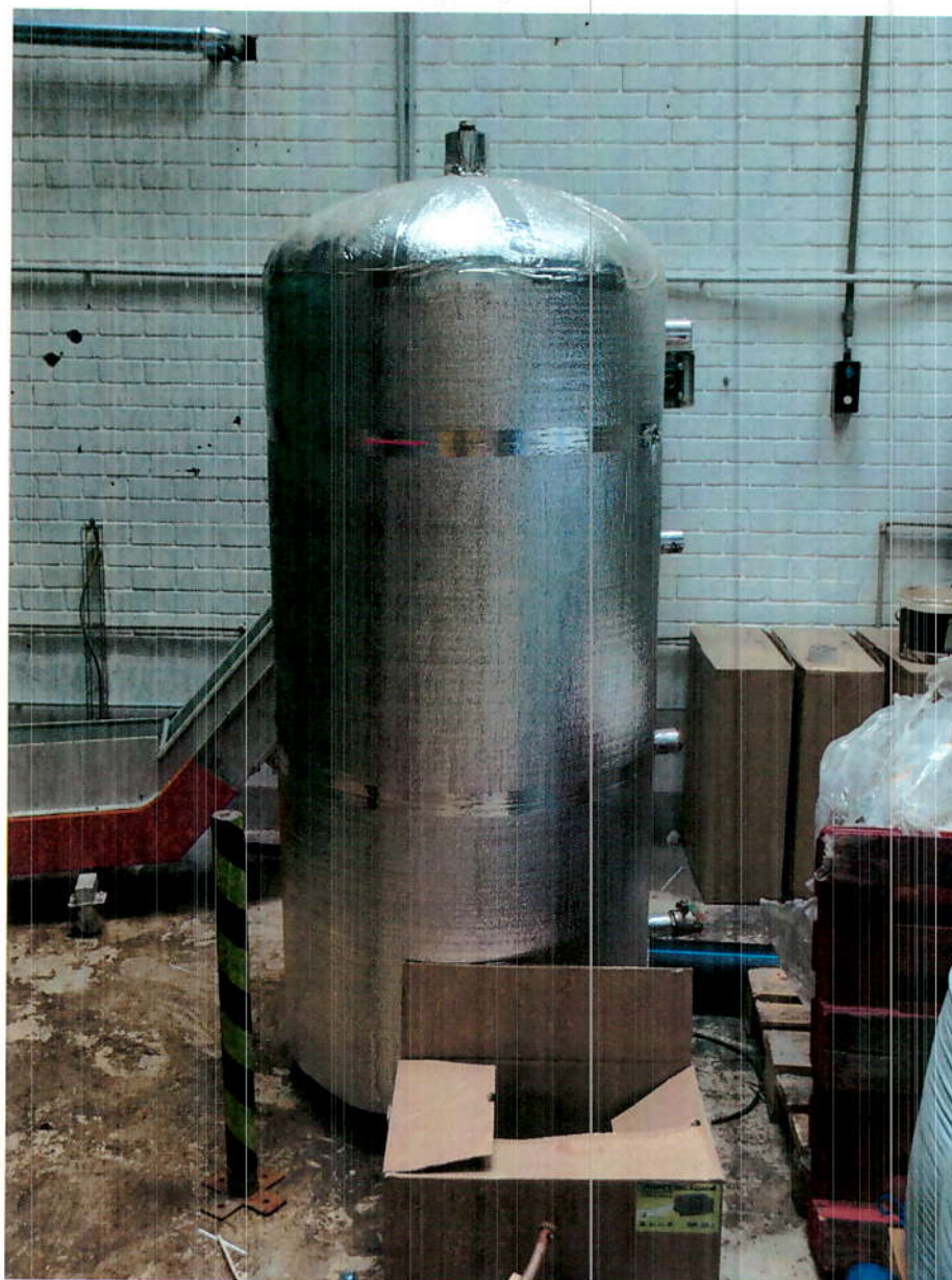
Obr. 47. Pol. 47: tlaková nádoba k chladicímu zařízení, cca 300l
