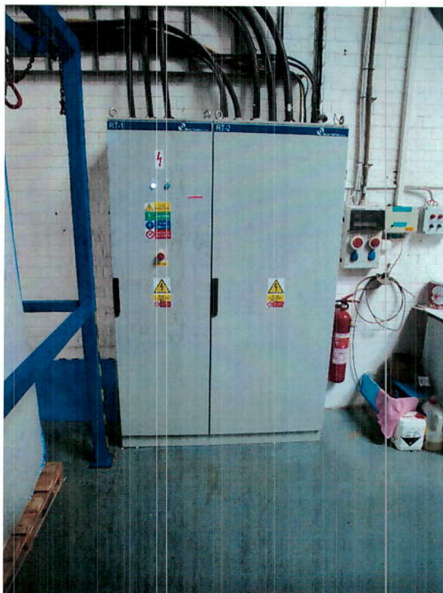
Obr. 30. Pol. 30: Hlavní rozvaděč technolog. praní plastů
