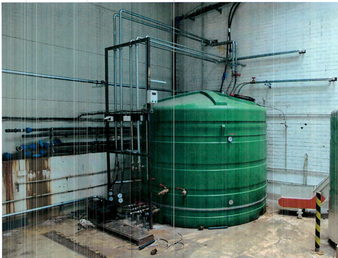
Obr. 48. Pol. 48: zásobník vody zelený + 2 čerpadla
