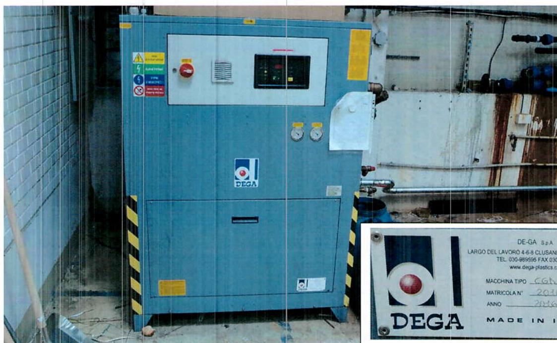
Obr. 49. Pol. 49: chladicí zařízení DEGA CGD450-A
