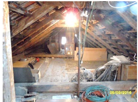
Pobled z koupelny do garáže, vpravo dveře na schodiště vedoucí na půdu; půdní prostory – krov se viditelně blíží konci životnosti
