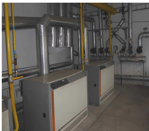
v kotelně najdeme tři kotle, funkčnost nebyla prokázána systém je nutno zrevizovat
