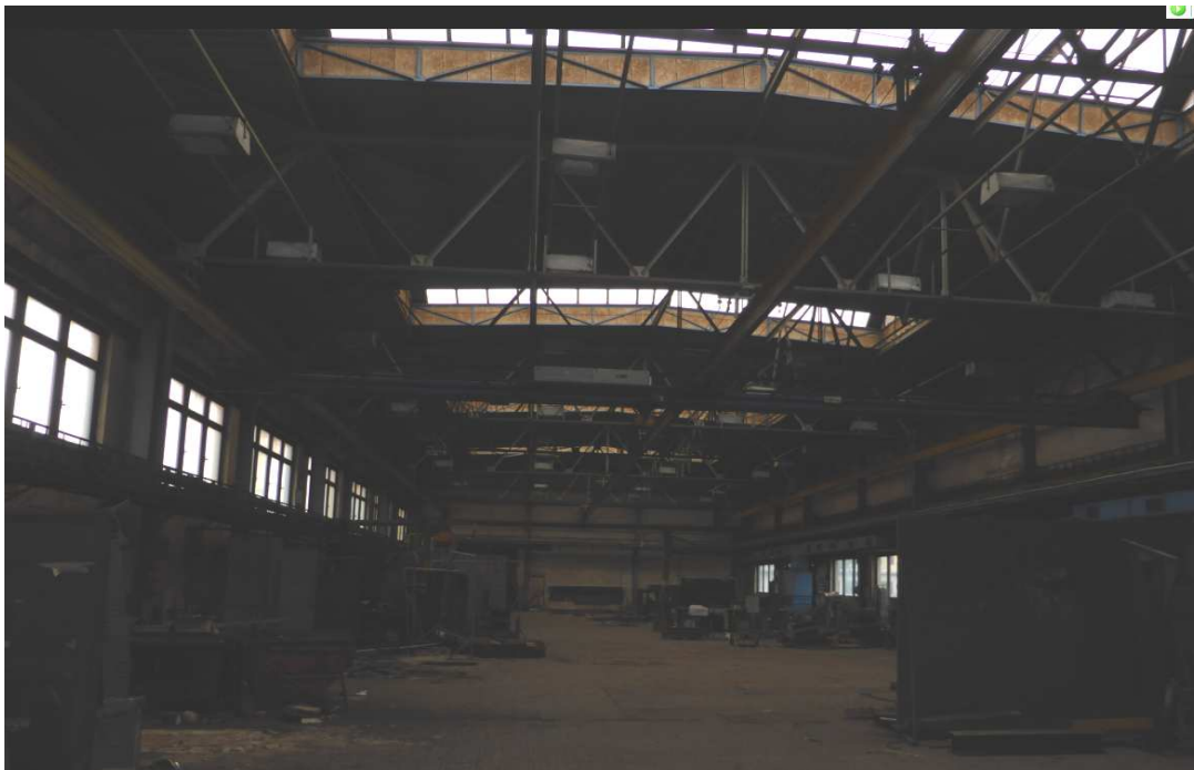
hlavní výrobní prostor haly č. 193, střechu vynáší ocelové vazníky
