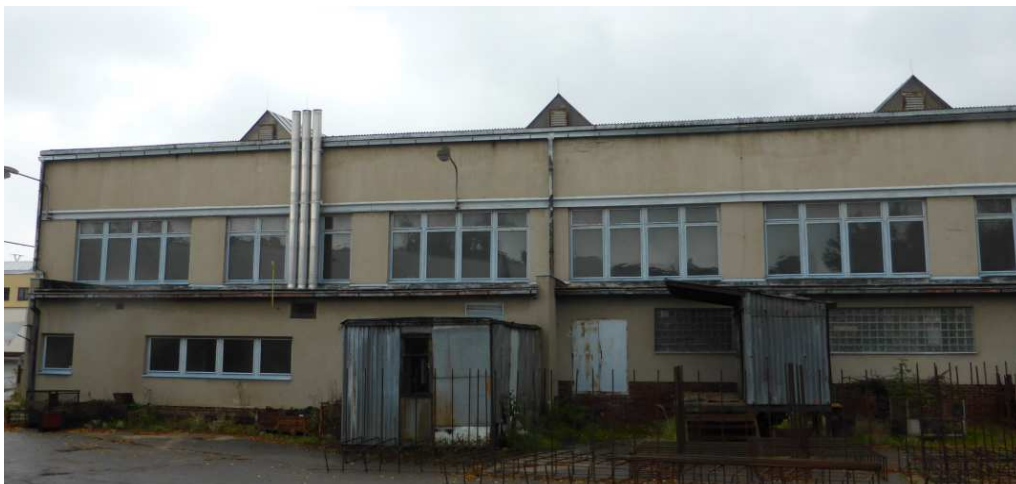
severní průčelí a přístavek s kotelnou, nové kovové komíny od plynových kotlů
